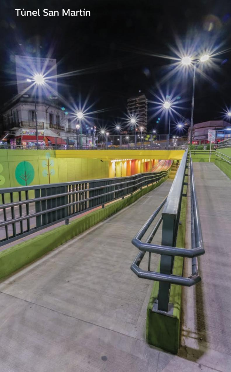
En los nuevos túneles bajo nivel que se han construido recientemente en la Ciudad se colocaron artefactos modelo Greenway, con ingeniería y producción de industria argentina. Se instalaron módulos de 48 y 96 LEDs, según el requerimiento, con temperatura de color blanco neutro.
