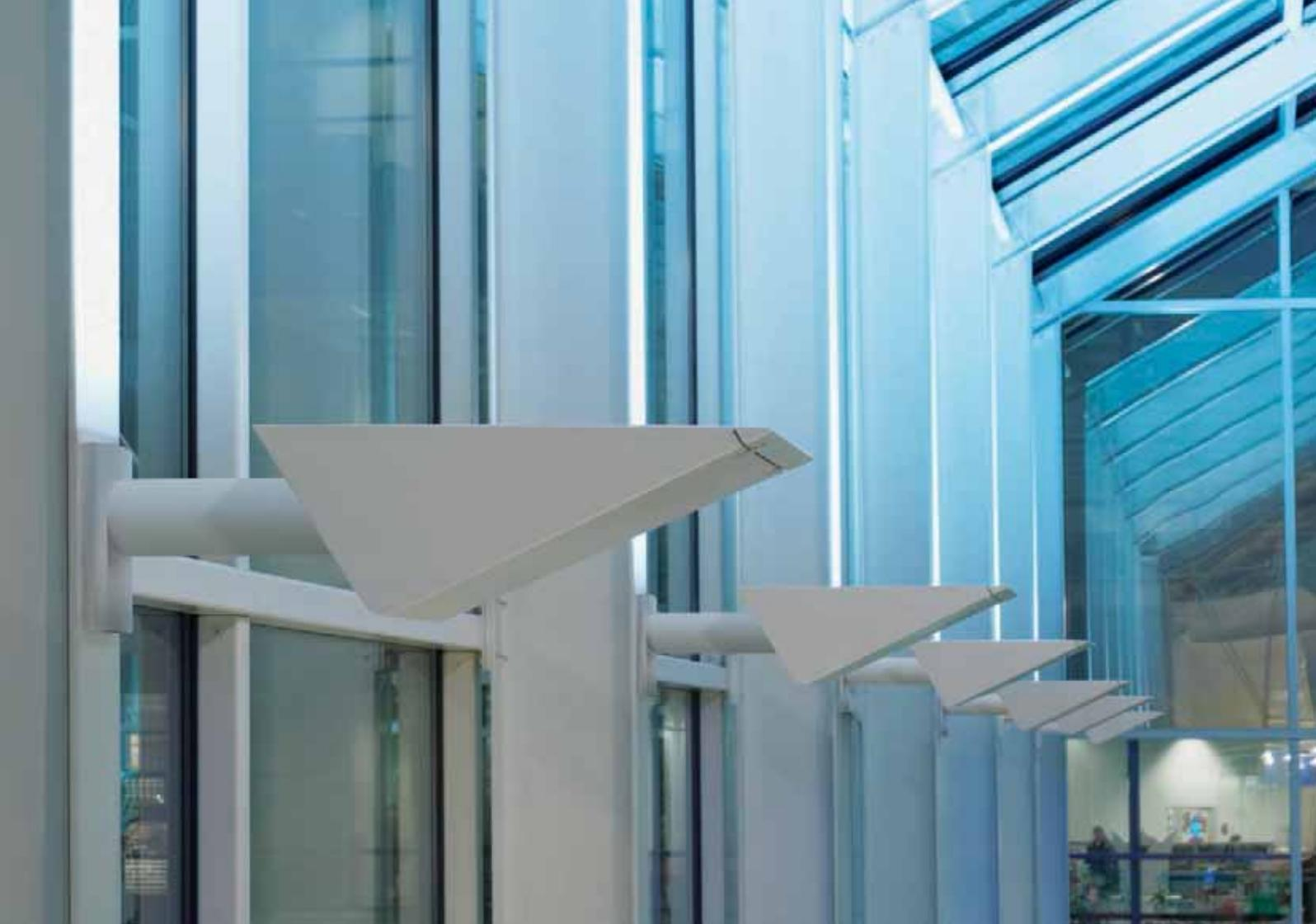
Pour l'installation et le remplacement de la lampe, l'accès se fait en ouvrant simplement le châssis qui retient la vitre frontale trempée.
