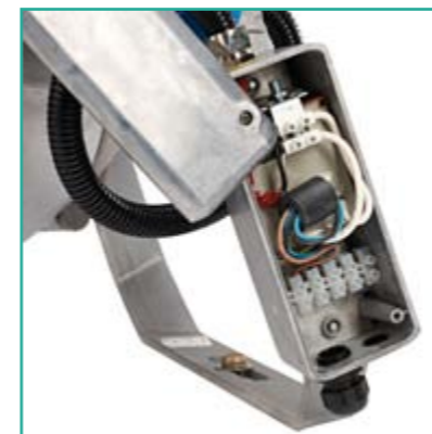
Detalhe da caixa de conexão
