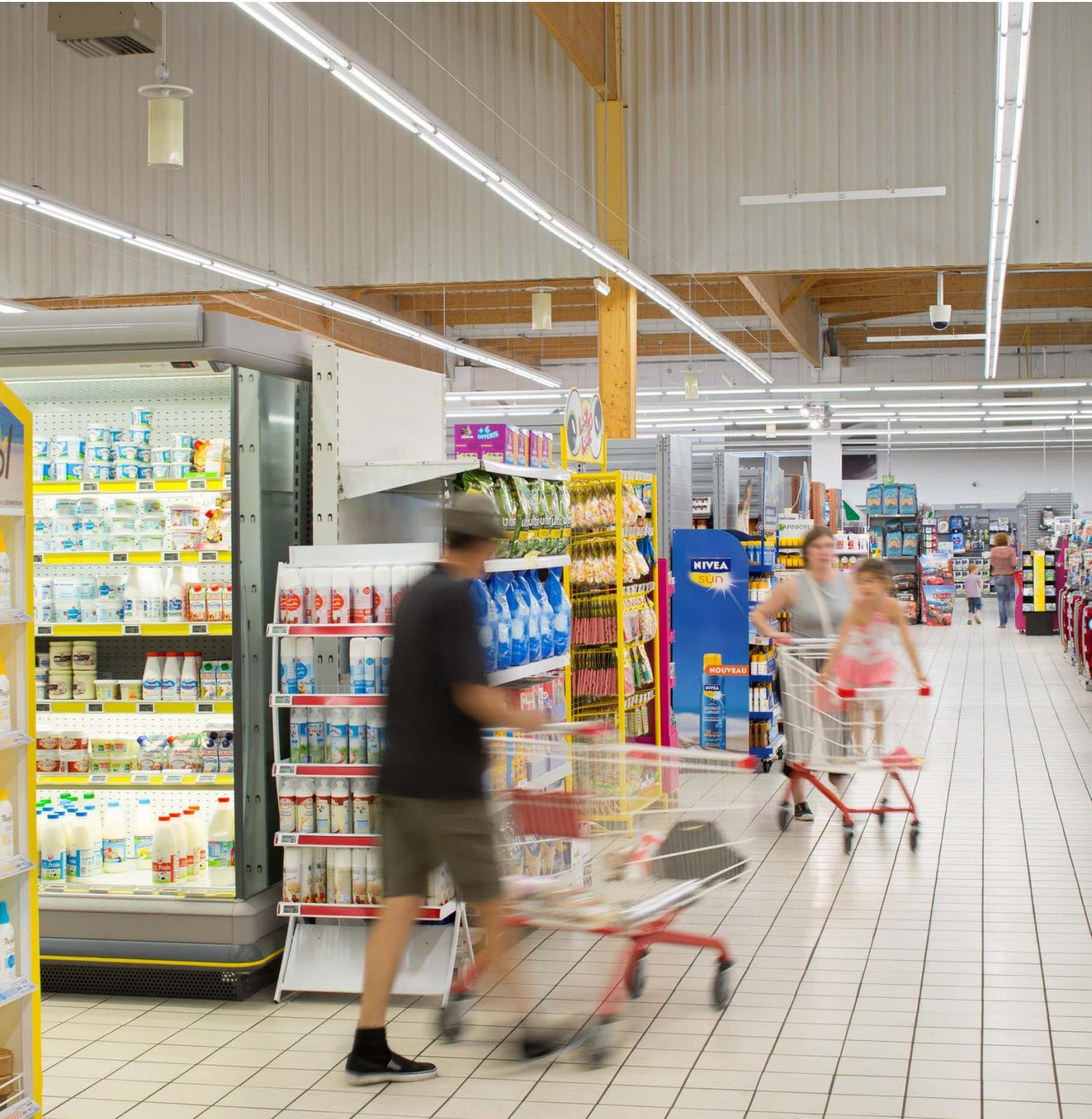
Un relamping total du magasin réalisé avec des lampes MASTER LEDtube installées à 3,50 mètres du sol offrant une efficacité lumineuse de 88 lum/W. En tout, 930 tubes LED ont été posés pour éclairer les 2400 m<sup>2</sup> du magasin.
