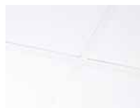
Système Soundlight Comfort Ceiling A éteint
