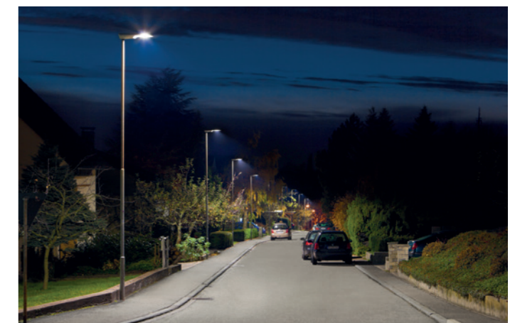
LED-Technik nach der Sanierung
