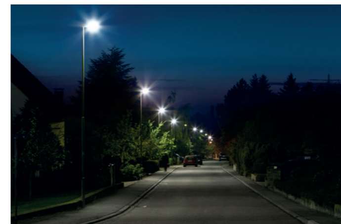
Konventionelle Technik vor der Sanierung
