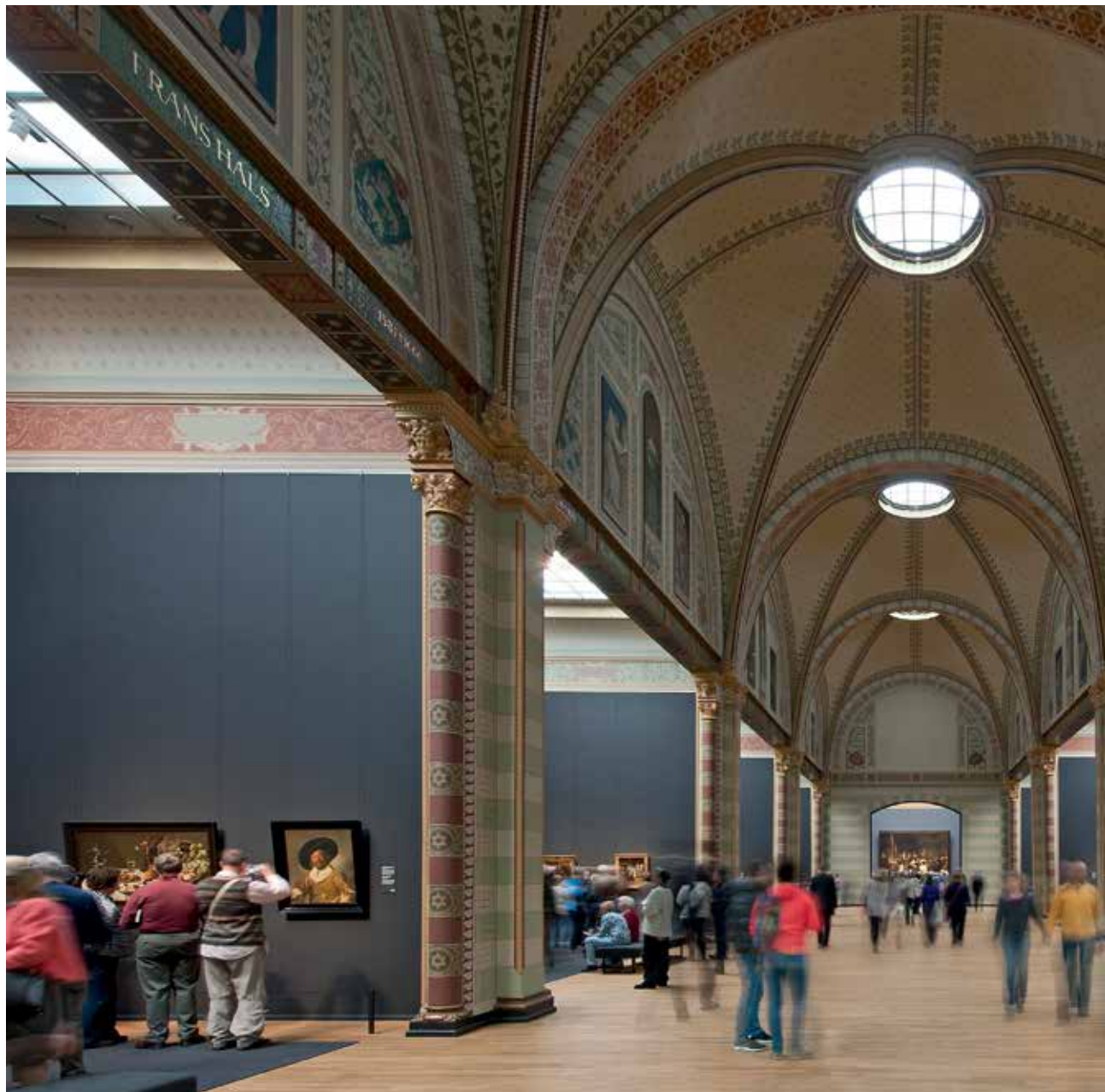
I lucernari sono lievemente bombati, a mò di cupola, e sormontati da luci fluorescenti insieme ad altri essenziali equipaggiamenti tecnici
