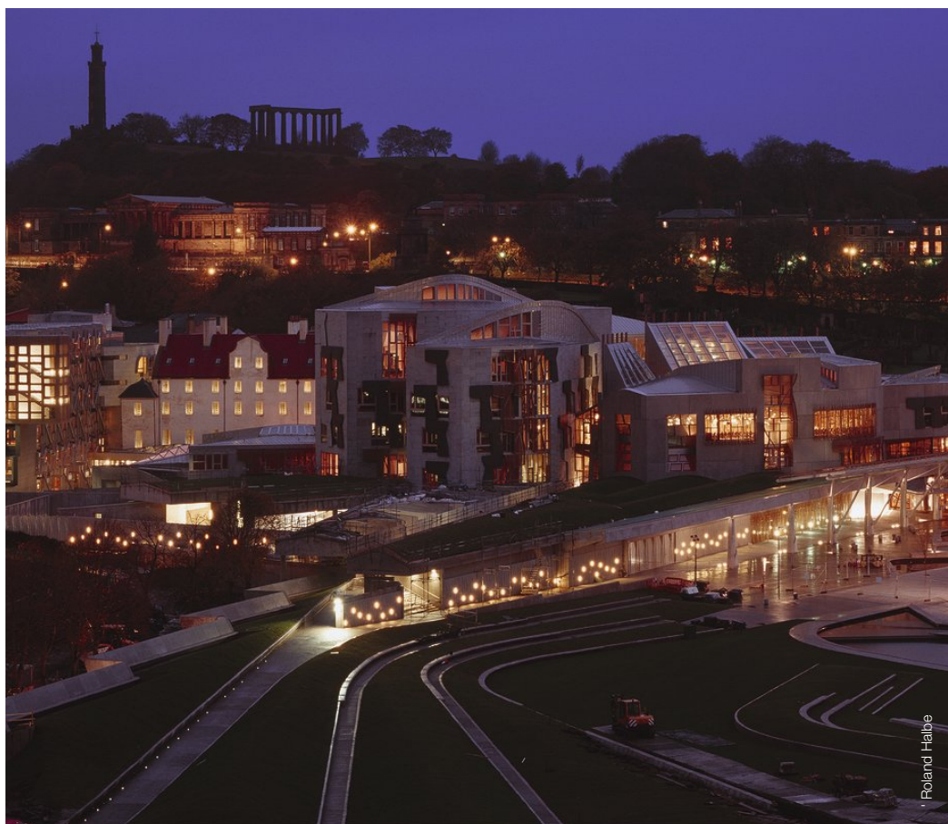
Presso il complesso del Parlamento scozzese, Edimburgo, Regno Unito, l'illuminazione funge da strumento di orientamento che aiuta i visitatori a spostarsi di notte.
