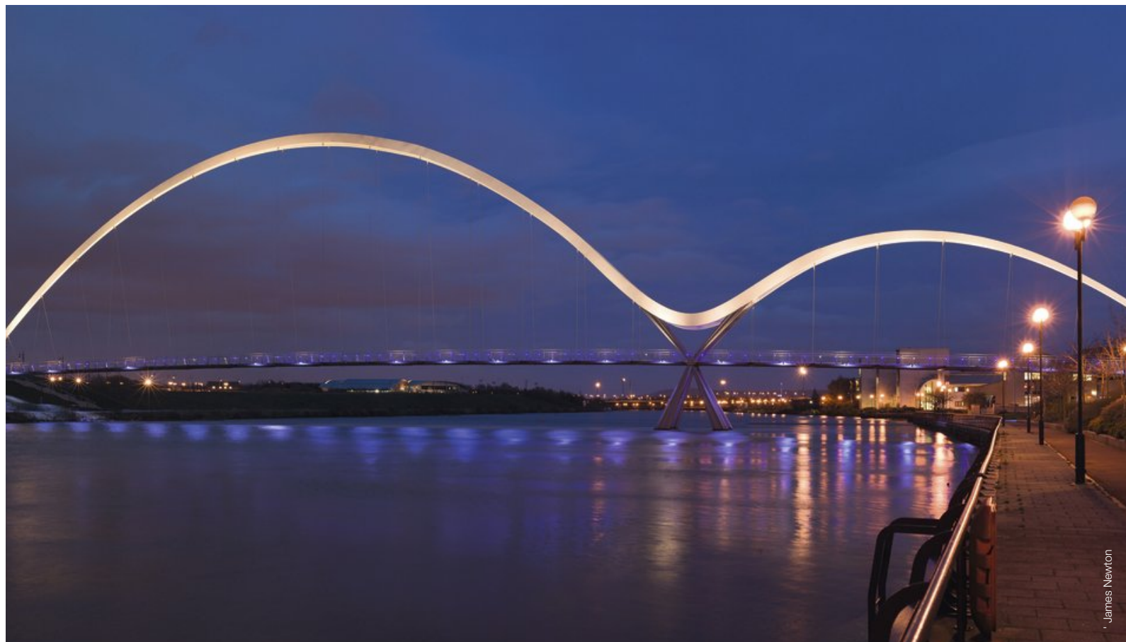
illuminazione interattiva per passaggio pedonale, Infinity Footbridge, Stockton-on-Tees, Regno Unito. Architetto concept: Stephen Spence. Progetto illuminotecnico: Speirs + Major.
