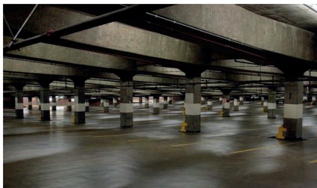
Immagine a sinistra: "Coltre di luce" CoreLine con fascio largo in un parcheggio al coperto. Immagine a destra: luce insufficiente e punti bui a causa della sostituzione di apparecchi tradizionali con apparecchi con un fascio lambertiano.
