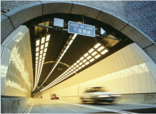
Fig. 5.11 Contraste entre la superficie de la carretera y las paredes de un túnel.
