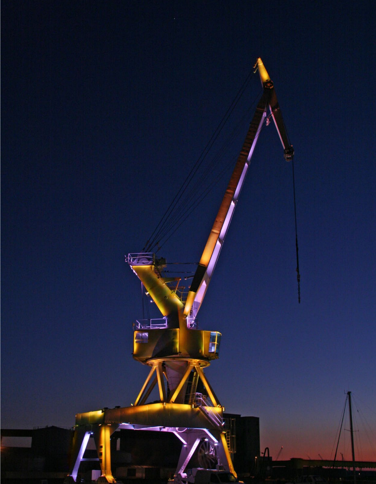
La grua Caillard Gran puerto marítimo de La Rochelle Concepción y fotografía : Sylvain Bigot, Néolight Instalación : Citeos Guilbaud
