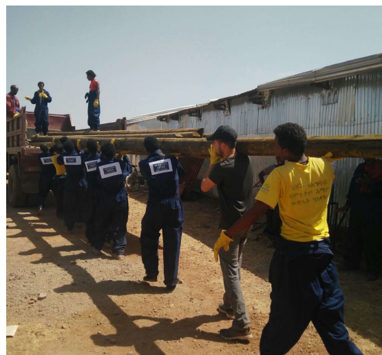
Transporte de postes de madera para la extensión de la red eléctrica. Fuente propia
