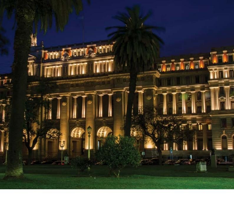
Las luminarias están dispuestas de manera que la iluminación se proyecta sobre la fachada por medio de haces concentrados y en forma rasante obteniendo una adecuada uniformidad y mínima dispersión de la luz.El proyecto lumínico de Philips Lighting está enfocado en la eficiencia, con soluciones de bajo consumo a partir del uso de LEDs de alta emisión.
