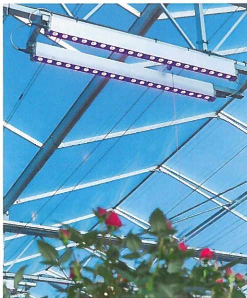
In plaats van dwars hangen de LED-modules nu parallel aan de tralies.
