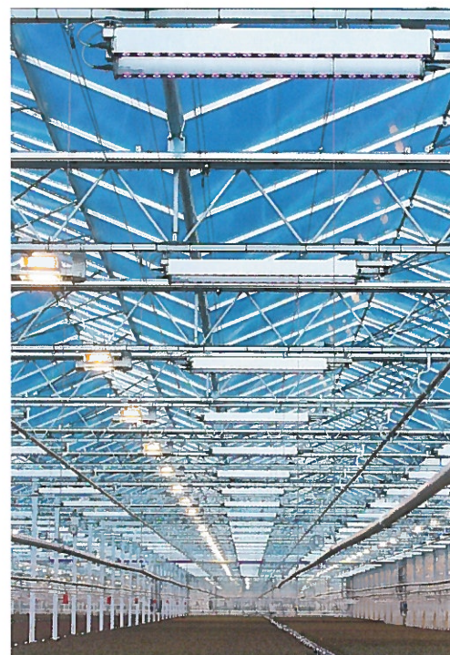
Het lichtplan is zo opgesteld dat lichtverdeling altijd uniform is, zowel bij het gebruik van alleen LED, SON-T of hybride belichting.
