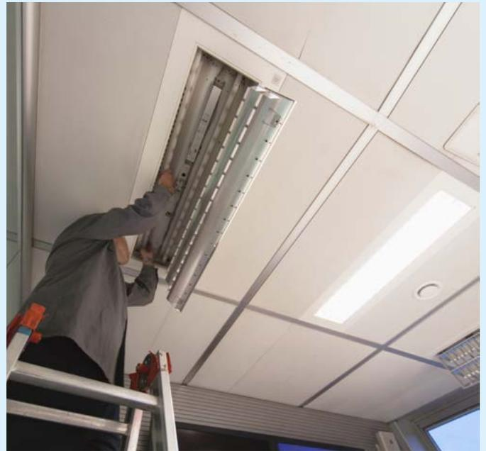
**Master LEDtube value HF es completamente compatible con equipos electrónicos, sin necesidad de realizar una nueva instalación ni cableado, el cambio, de tipo Plug & Play, se realiza sustituyendo unos por otros.**
